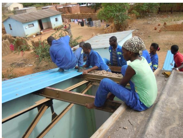
Junge MetallbauerInnen decken das Kirchendach neu, nach einem Sturmschaden
