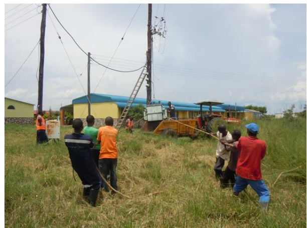
Der Transformator wird ersetzt
