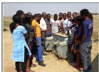
Elektrikerklasse beim Anschauungsunterricht
