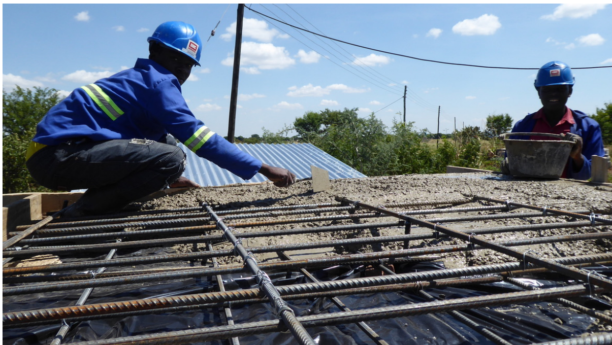
Ehemalige Maurerlehrlinge beim Betonieren
