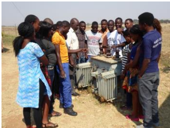
Elektrikerinnen und Elektriker
