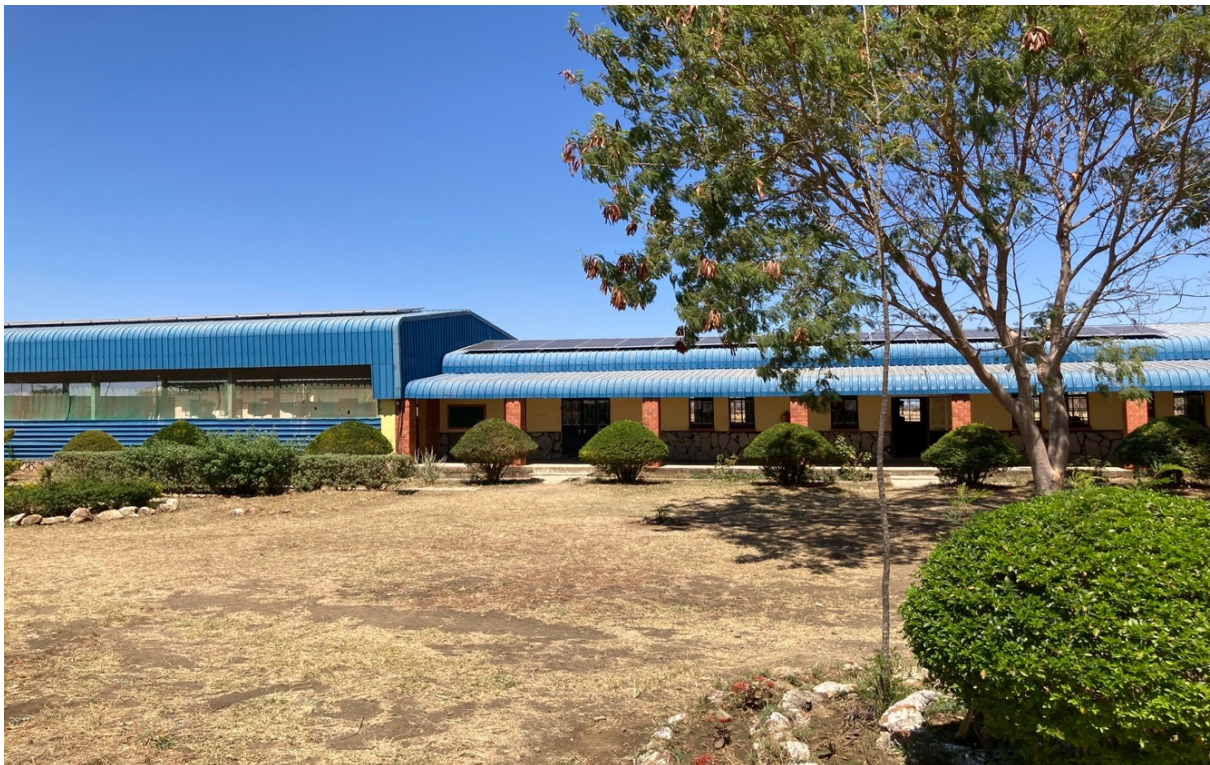
Berufsschulhaus und Werkstätten mit der neuen Solaranlage auf dem Dach (rechts)
